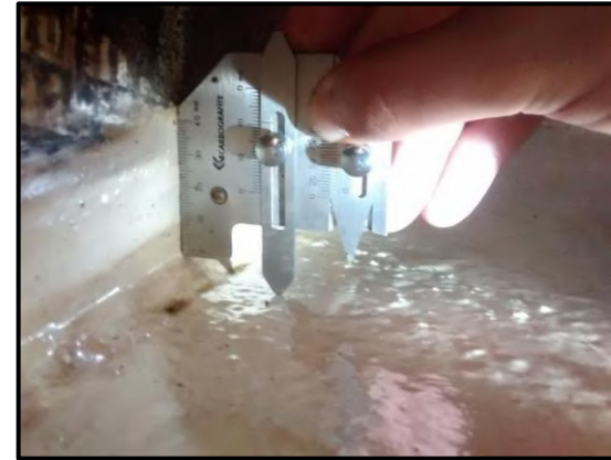
Dimensional na solda de ligação costado e fundo (externo e interno)
